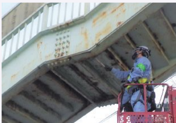
構造物の点検
