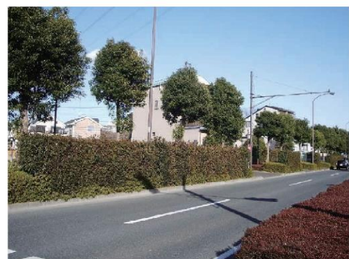
騒音の防止に配慮した緑化（東八道路）
