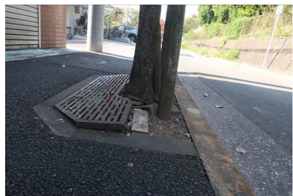
根上防止蓋の持ち上げによる段差
